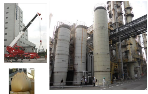
実用化された硫化水素吸着剤の充填の様子
